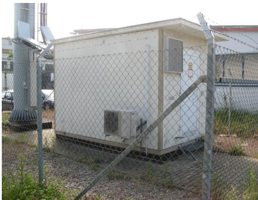
Rysunek 54 Przykładowe ogrodzenie wieży i kontenera.
