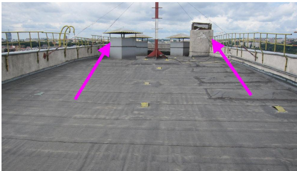
Rysunek 16 Miejsce na usytuowanie nowej stacji bazowej AIS – RIS. Centralnie widoczny maszt piorunochronu – do wykorzystania dla anteny VHF.
